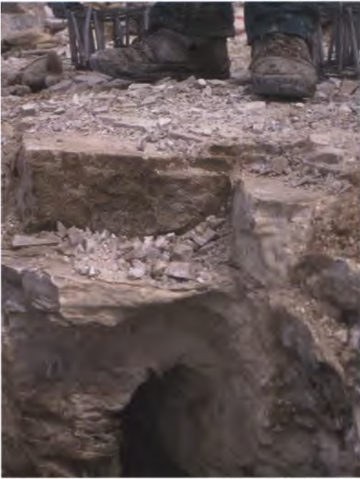
Abb. 7: Schachteinstieg in der Trasse am Steinbuckel, der durch Abheben einer einzigen Gesteinsplatte freigelegt werden konnte.
