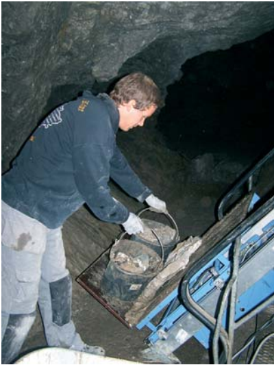
Transportband aus der Höhle nach draußen zum Container; Fotos: A. Ipsen
