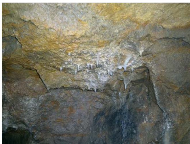
Abb. 6: Tropfsteinbildungen an Tropfstellen, die feinste wasserleitende Lineamente im Gestein der Decke nachzeichnen
