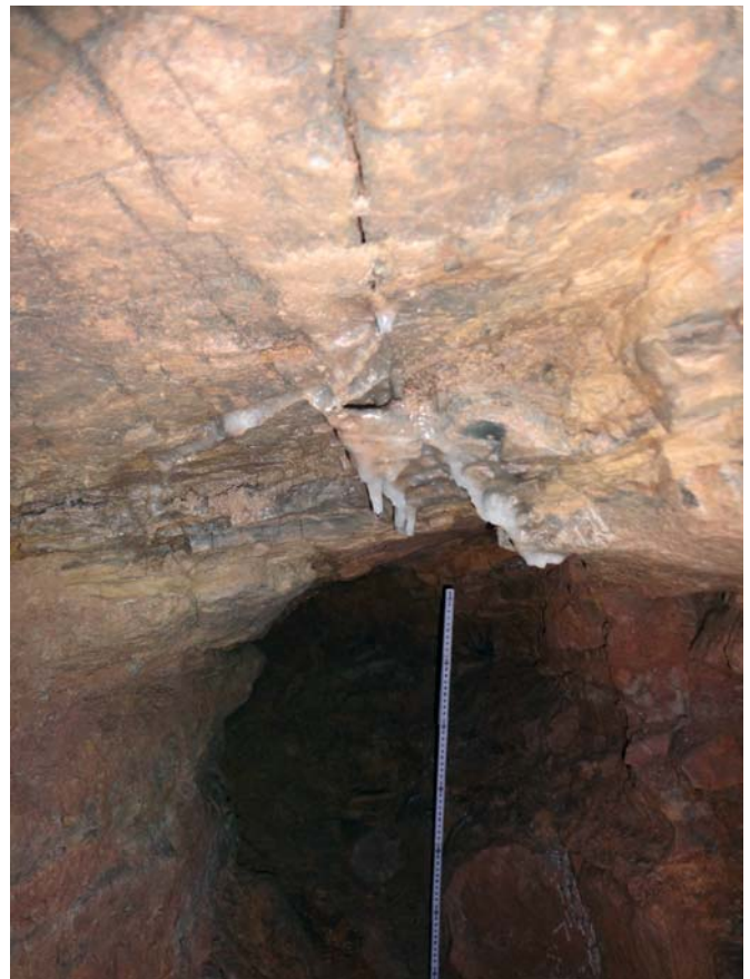
Abb. 10: Tropfwasserzutritte aus geöffneten Kluffugen in Gesteinen der Tonplattenfazies oberhalb eines phantomisierten Bereiches. An der Decke sind kleine Sinterröhrchen durch austretendes Tropfwasser entstanden.
