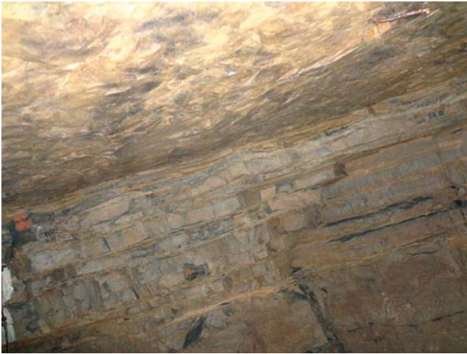
Abb. 2: Rippelbildungen sind im Stoß der abgebauten Gesteine und wellenförmig am Top der Decke einer Abbaukammer zu erkennen.
