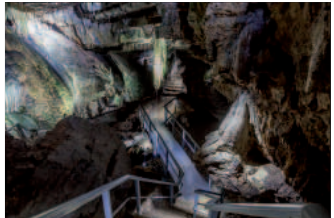
Abb. 1: Die neue LED-Beleuchtung und GFK-Wegekonstruktion unterhalb des Tempels am Bachgang; Foto Gemeinde Hasel
