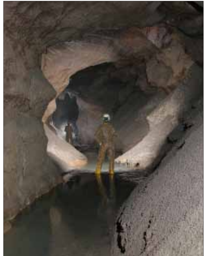
Abb. 9: Der Erdbachtunnel im östlichen Abschnitt
