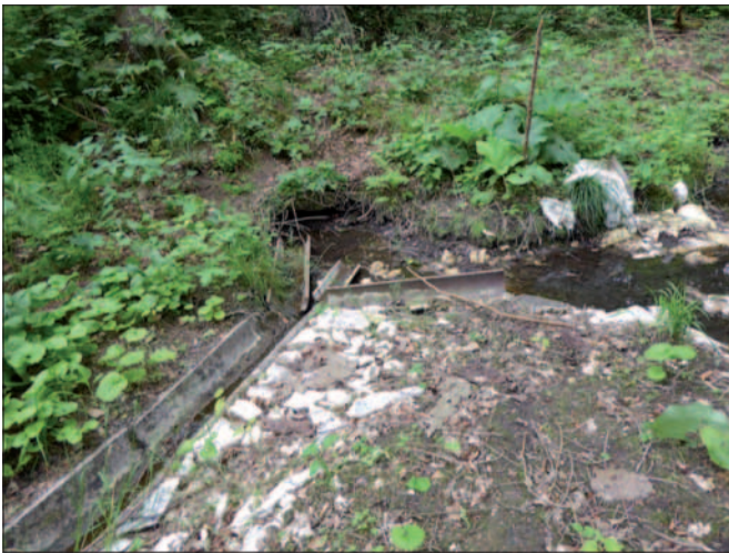
Abb. 7: Zustand des Quelltopfs am 12.6.2022 bei geringer Wasserführung; die wegen der Ölaustritte verlegten halben Tonrohre sind inzwischen von unbekannter Seite neu „geordnet“ worden; Foto Fritz Reinboth.
