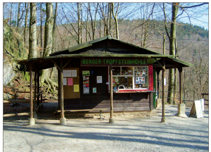
Abb. 9: Kiosk am historischen Höhleneingang durch das Pfannenberg-Abri und über den Hauptmann-Spatzier-Stollen, 2007 abgerissen; Foto J. Lüttge.
