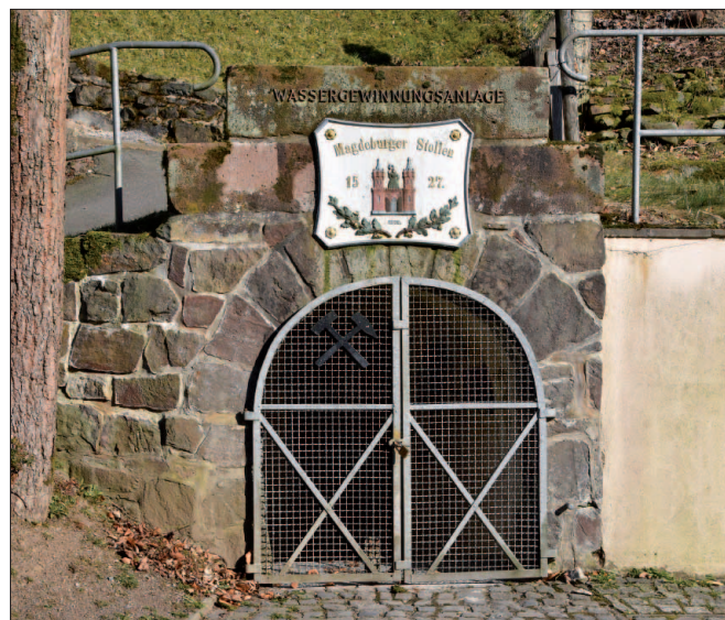
Abb. 3: Mundloch des Magdeburger Stollens 2022; Foto Migeber, de.wikipedia.org/wiki/Datei:H%C3%BCbichweg_Magdeburger_Stollen_(Bad_Grund)_03.jpg .
