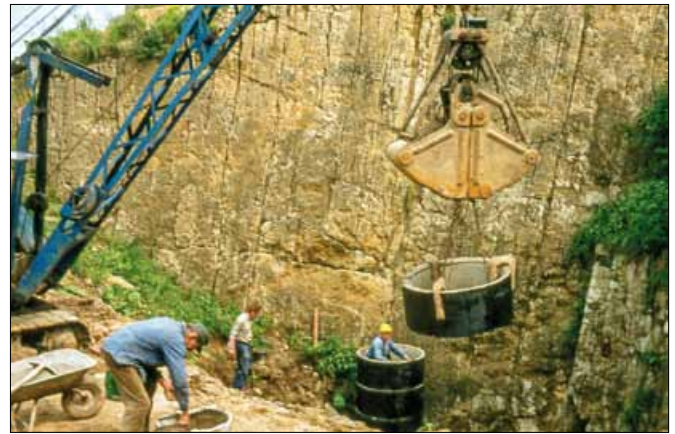
Abb. 2: Sicherung des Eingangs; Foto Hans Schmidt 1965.
