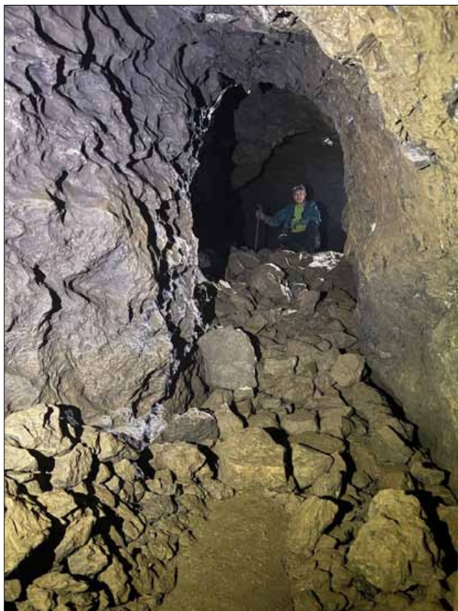
Bismarckhöhle vor der Sanierung; Foto S. Voigt.
