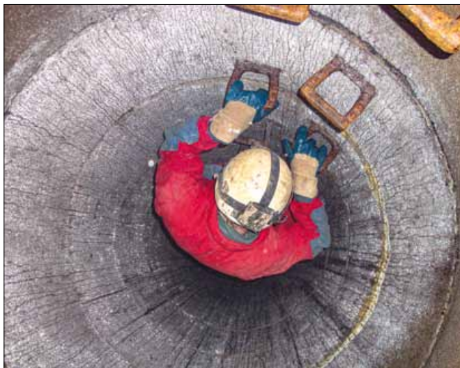
Abb. 5: Abstieg in den Röhrenschacht; Archiv ArGeKH 2010.
