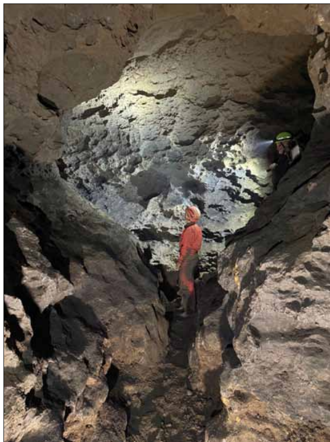
Bismarckhöhle nach der Sanierung; Foto S. Voigt.
